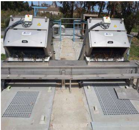
Nouveaux dégrilleurs installés
