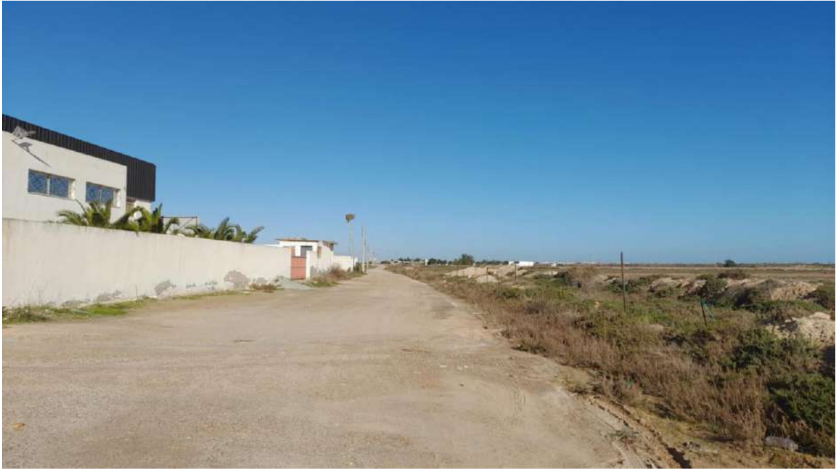
Sortie de la conduite des eaux épurées
