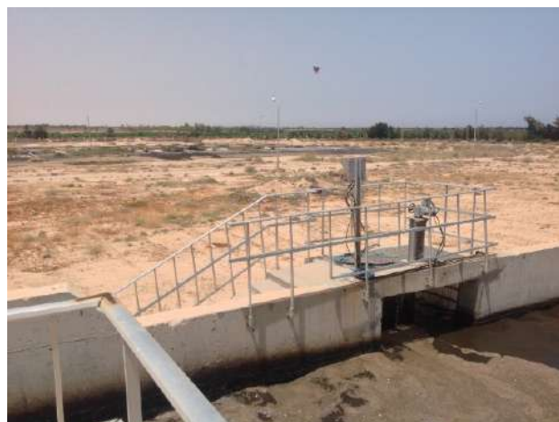
Vanne motorisée pour hauteur utile
