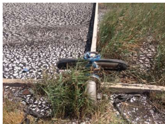
Vanne à volant grippée
