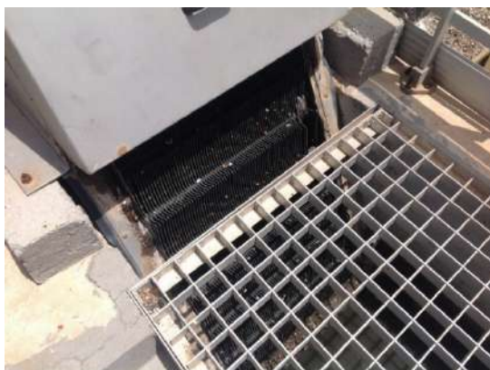
Dégrilleur automatique
