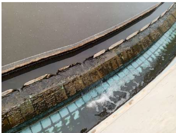
Décanteur secondaire
