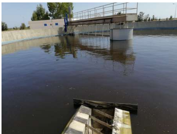
Décanteur secondaire
