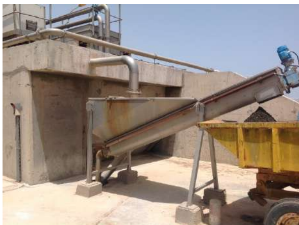
Classificateur et benne de réception
