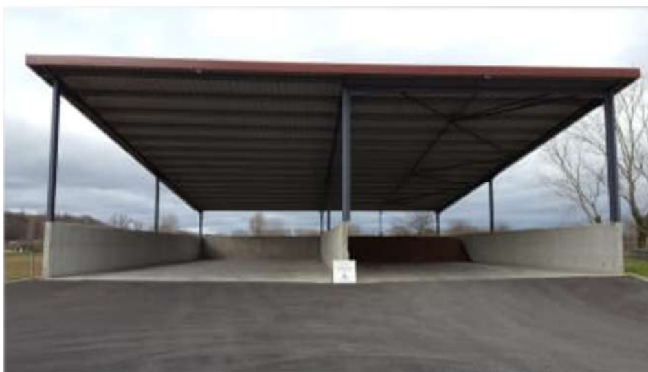
Figure 14 : Hangars de stockage de boues – Modèle type
