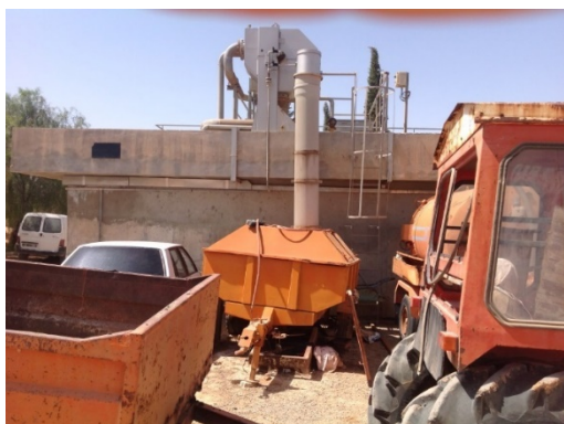
Benne de récupération des déchets
