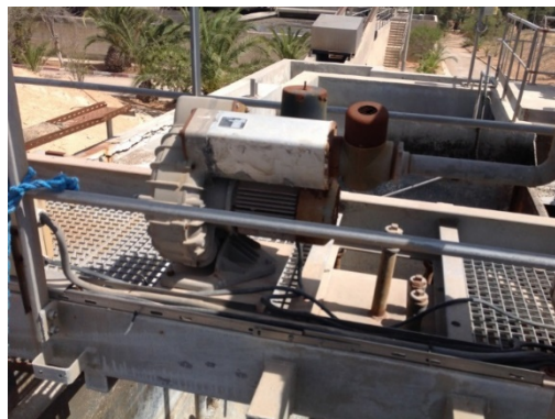
Surpresseur air-lift
