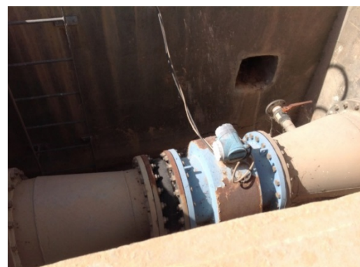
Débitmètre de sortie
