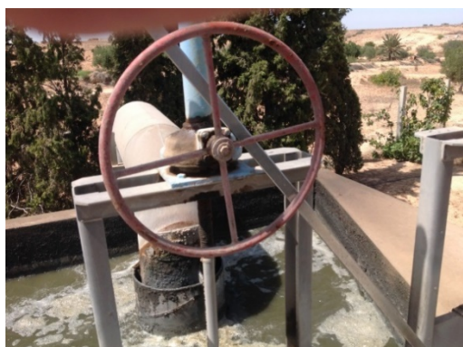
Bâche d'arrivée des eaux brutes et vanne
