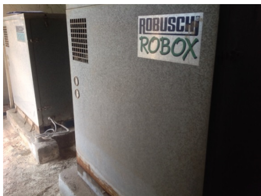
Surpresseurs dégraisseurs
