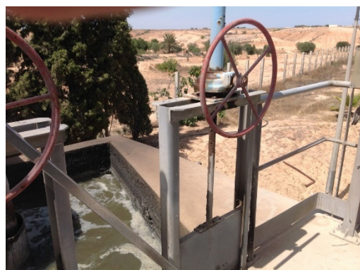
Etat des vannes
