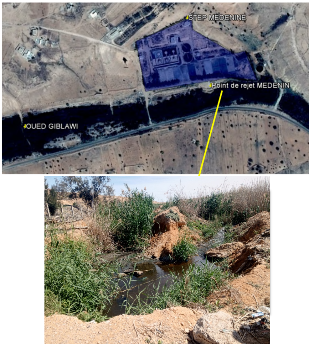
Figure 2 : Milieu et ouvrage de rejet des eaux épurées (ONAS, 2019)
