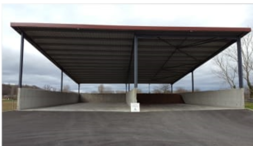
Figure 17 : Hangars de stockage de boues – Modèle type
