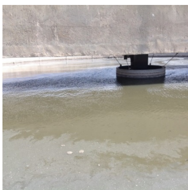
Vue partielle épaisseur à boues
