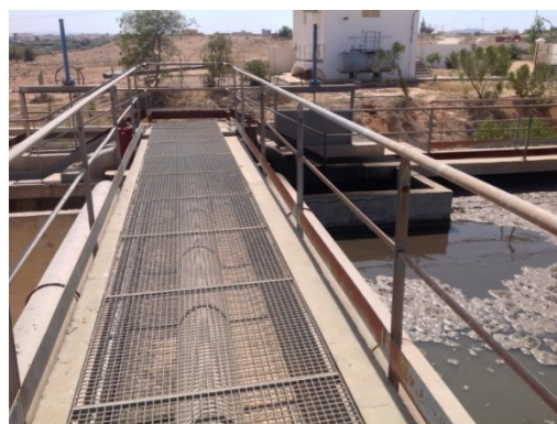
Vue partielle des deux zones d'anoxie
