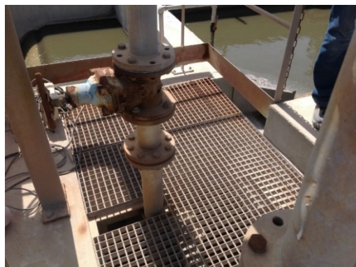
Relevage pompe à graisse
