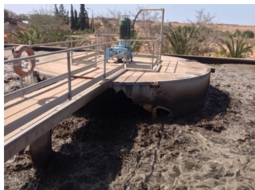
Turbine bassin d'aération
