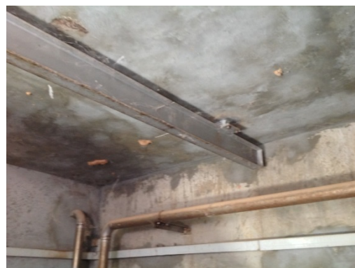
Levage pour maintenance surpresseurs
