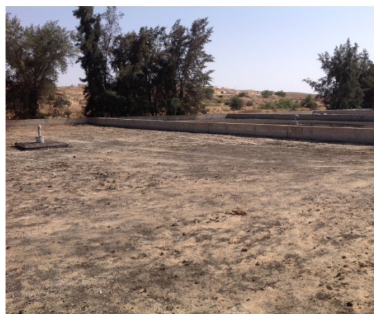
Alimentation centrale des lits
