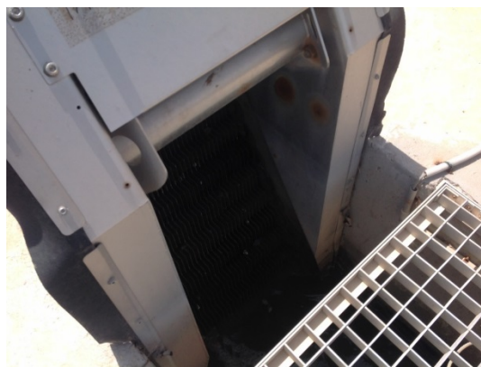
Dégrilleur automatique
