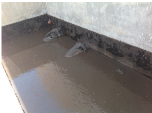
Vue partielle de la bâche à boues
