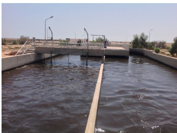
Vue partielle du chenal d'aération
