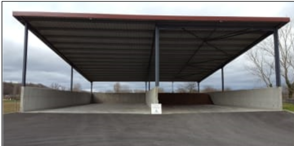
Figure 14 : Hangars de stockage de boues – Modèle type
