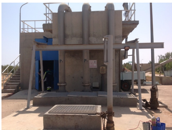
Vue partielle du poste de relevage
