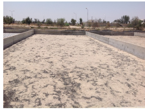
Vue partielle des lits de séchage
