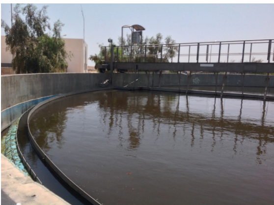
Partie d'entrainement du pont et aspect des eaux traitées
