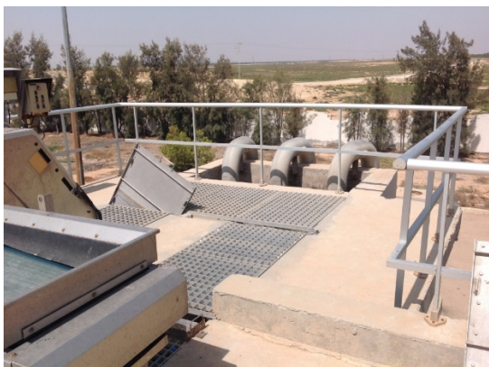
Batardeaux vers dégrillage
