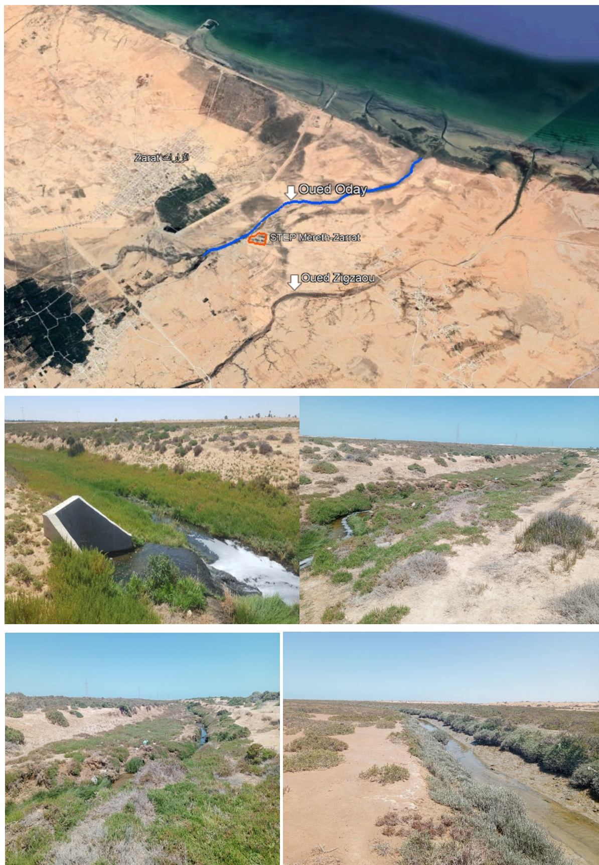
Figure 25 : Ouvrage de rejet des eaux épurées et zone aval de l'Oued Oudey (Avril 2024)
