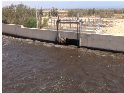
Vanne motorisée pour hauteur utile
