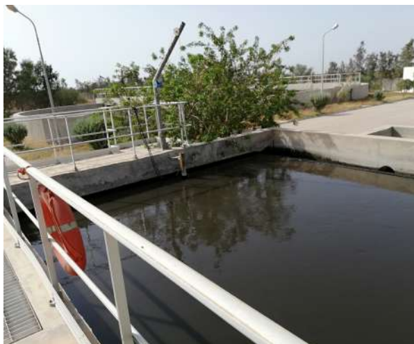
Bassin anaérobie de déphosphatation
