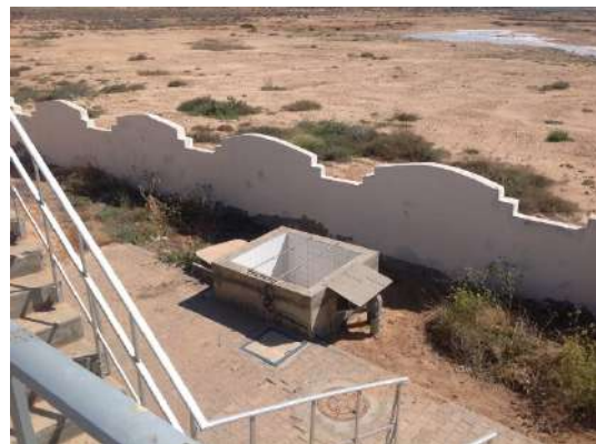
Désodorisation bache de dégazage
