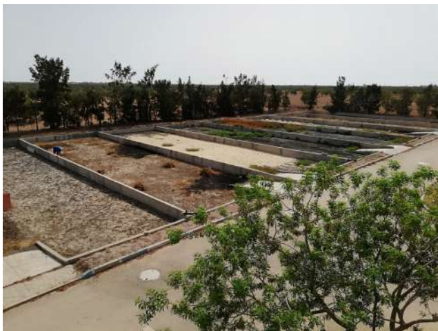
Lits de séchage des boues
