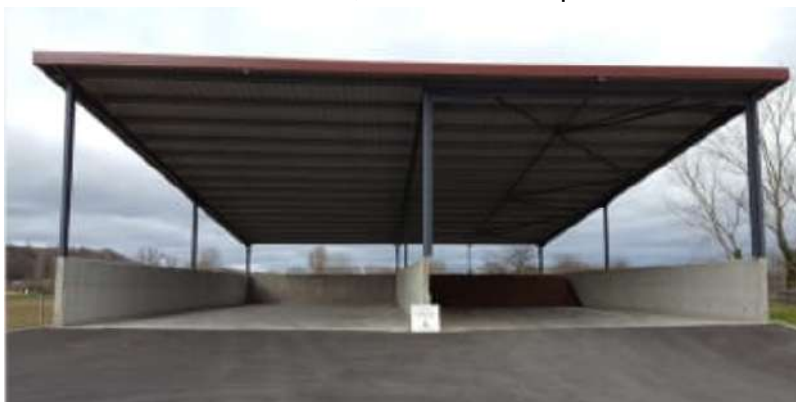
Figure 17 : Hangars de stockage de boues – Modèle type
