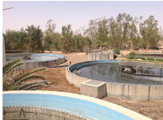
Vue d'ensemble du dégazeur répartiteur et des trois clarificateurs
