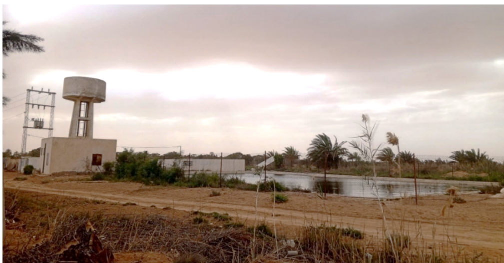
Figure 9 : Station de pompage du CRDA pour la réutilisation des EUT en irrigation (Avril 2024)
