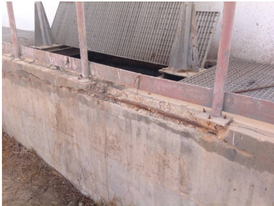
Bâche à boues et eaux de lavage
