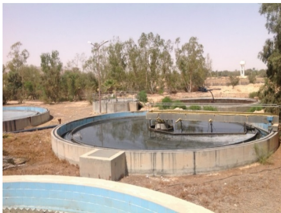
Vue d'ensemble du dégazeur répartiteur et des trois clarificateurs
