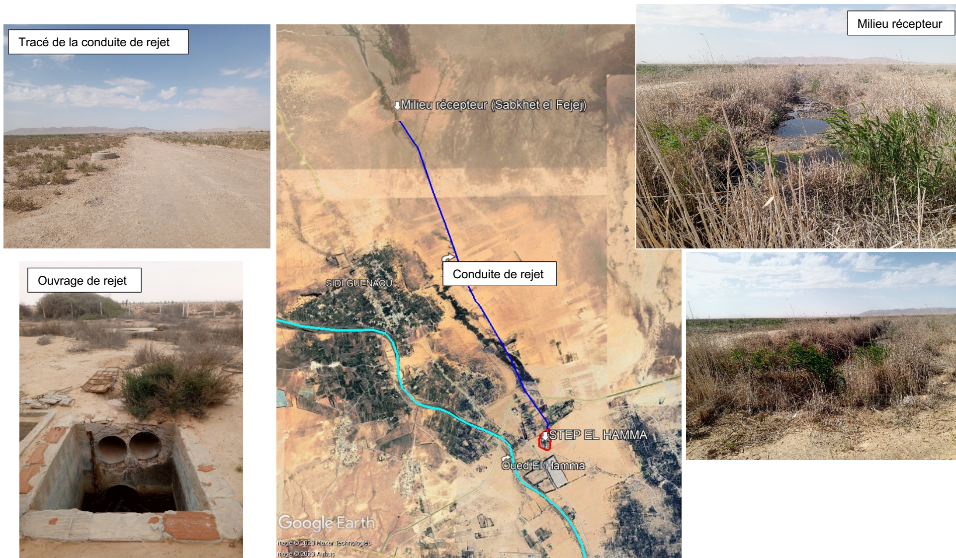
Figure 21 : Ouvrages de rejet des eaux épurées et milieu récepteur (Avril 2024)
