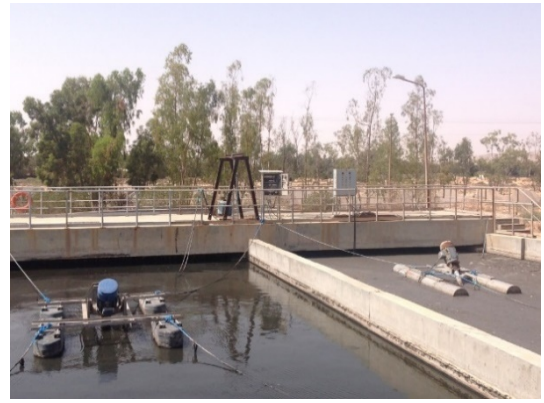
Aérateur de type oxystar sur chenal n°2
