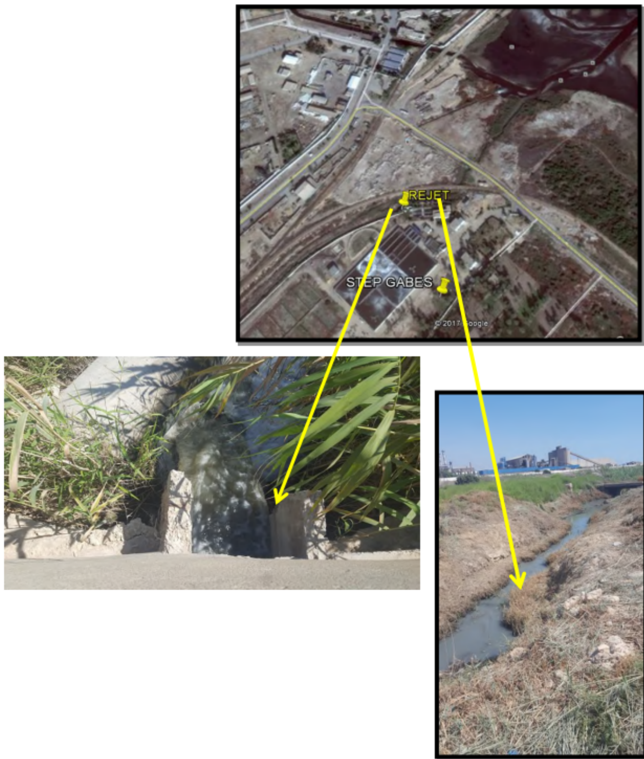
Figure 3 : Point et ouvrage de rejet des eaux épurées de la STEP de Gabès
