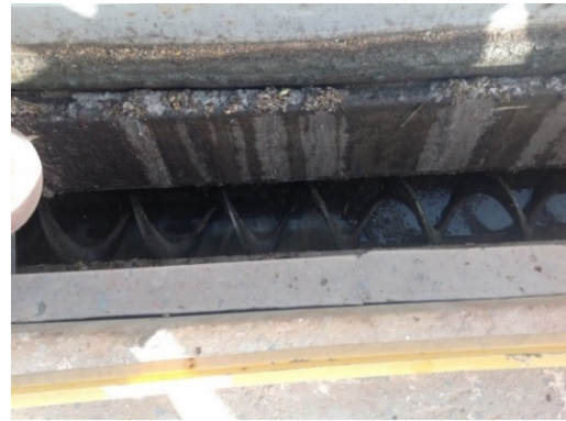
Vis sans fin de récupération des graisses
