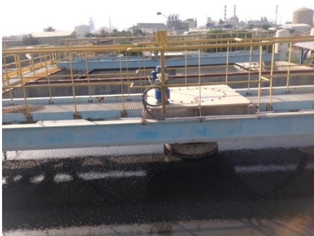
Vue partielle épaisseur à boues
