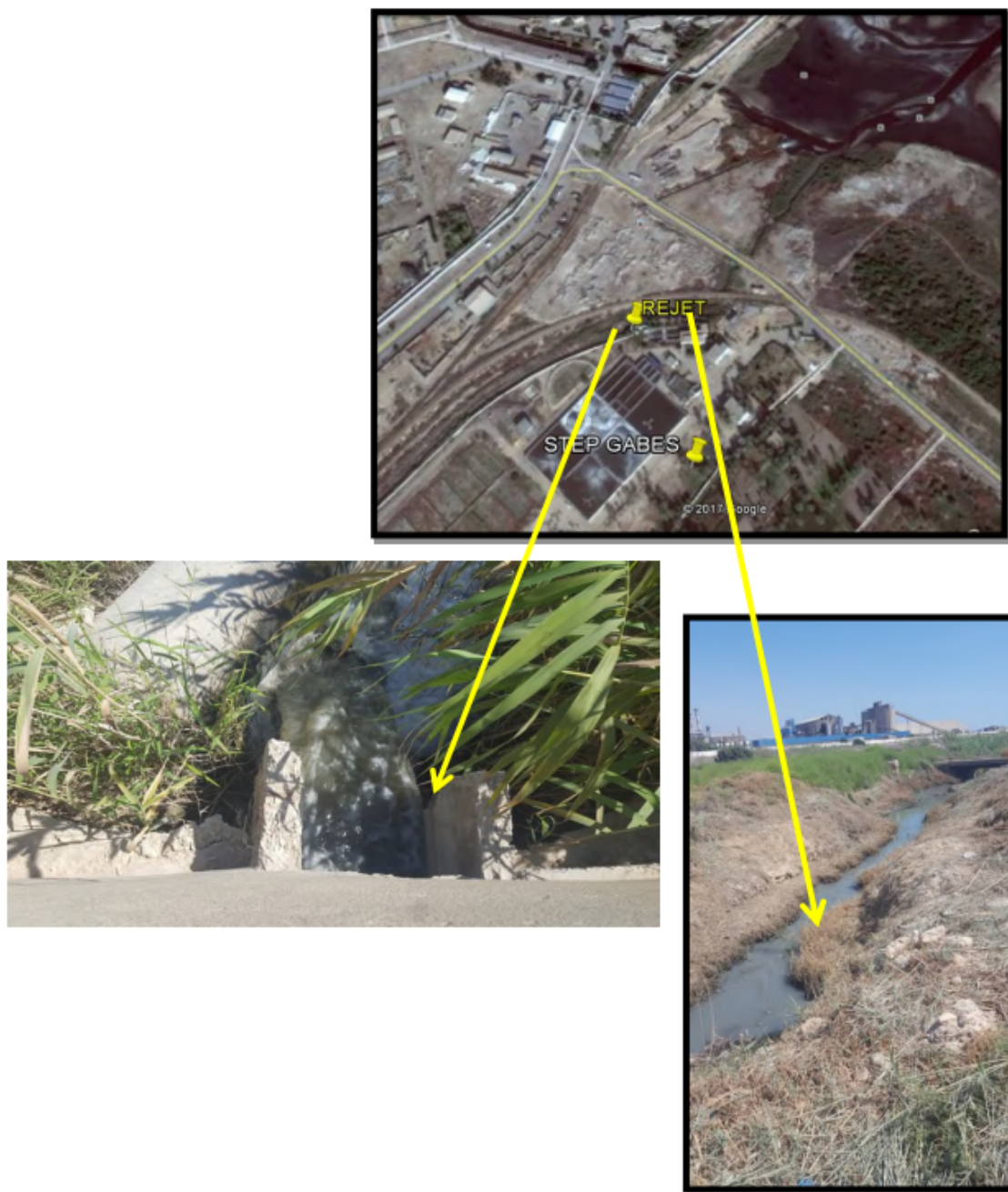
Figure 35 : Point et ouvrage de rejet des eaux épurées de la STEP de Gabès
