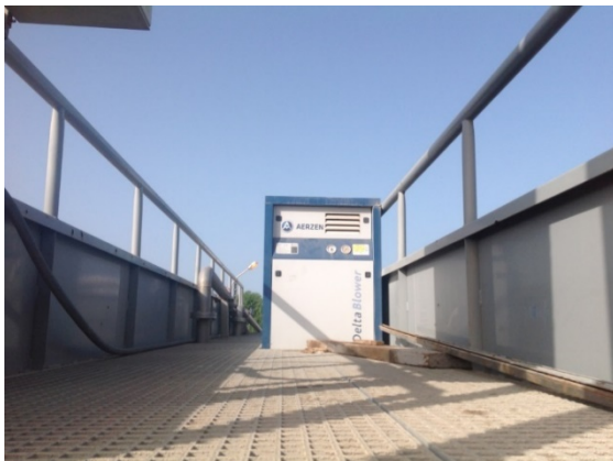
Surpresseurs Aerzen pour air-lift
