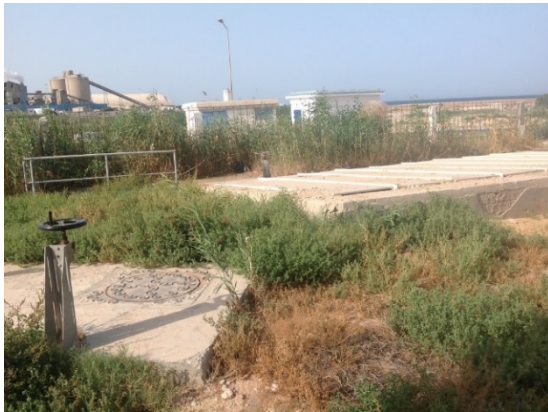
Vanne de by-pass général
