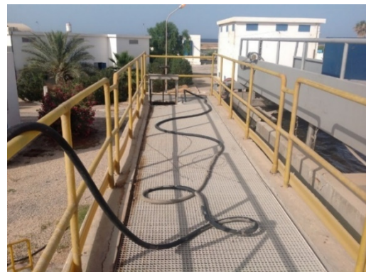
Vanne de by-pass des eaux prétraitées
