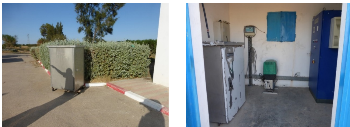
Figure 22 : Prélèyeurs en entrée et en sortie station H/S
