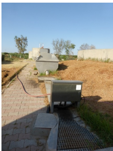
Figure 17 : Vue du canal de désinfection UV et de l'armoire UV
