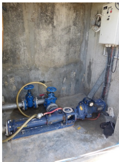
Figure 18 : Vue de l'épaississeur gravitaire et de la pompe d'alimentation de boues épaissies
