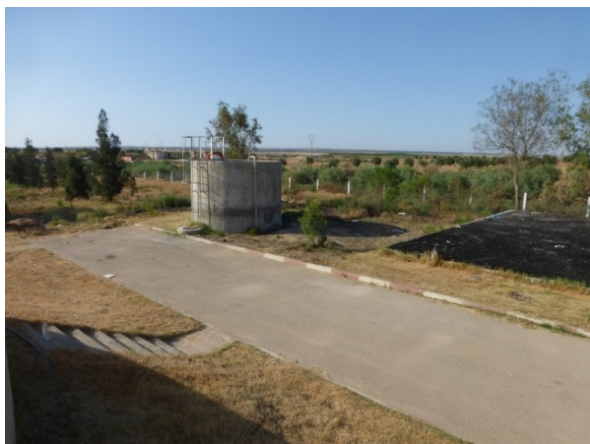
Figure 18 : Vue de l'épaississeur gravitaire et de la pompe d'alimentation de boues épaissies
