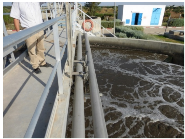
Figure 14 : Vues du bassin biologique avec la zone de contact au centre
