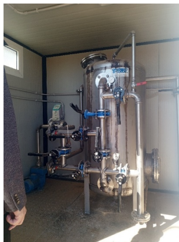
Pilote de filtration et désinfection (non fonctionnel)
