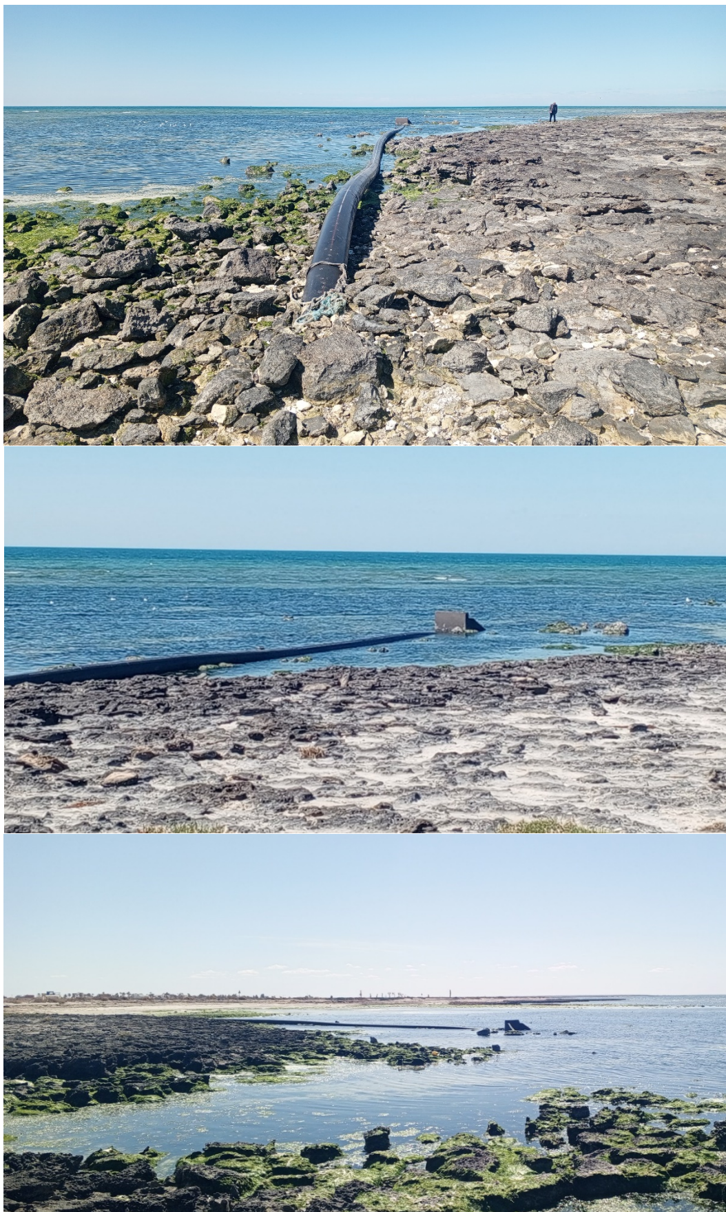
Figure 4 : Conduite et ouvrage de rejet des EUT
