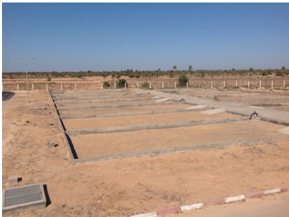
Vue partielle des lits de séchage
