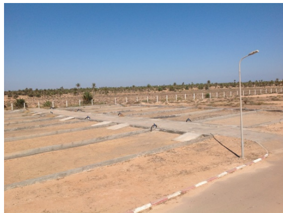
Vue partielle des lits de séchage
