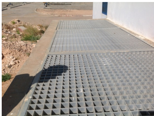
Vue partielle de la bêche à boues
