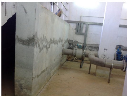
Vue partielle du local pompe à boues
