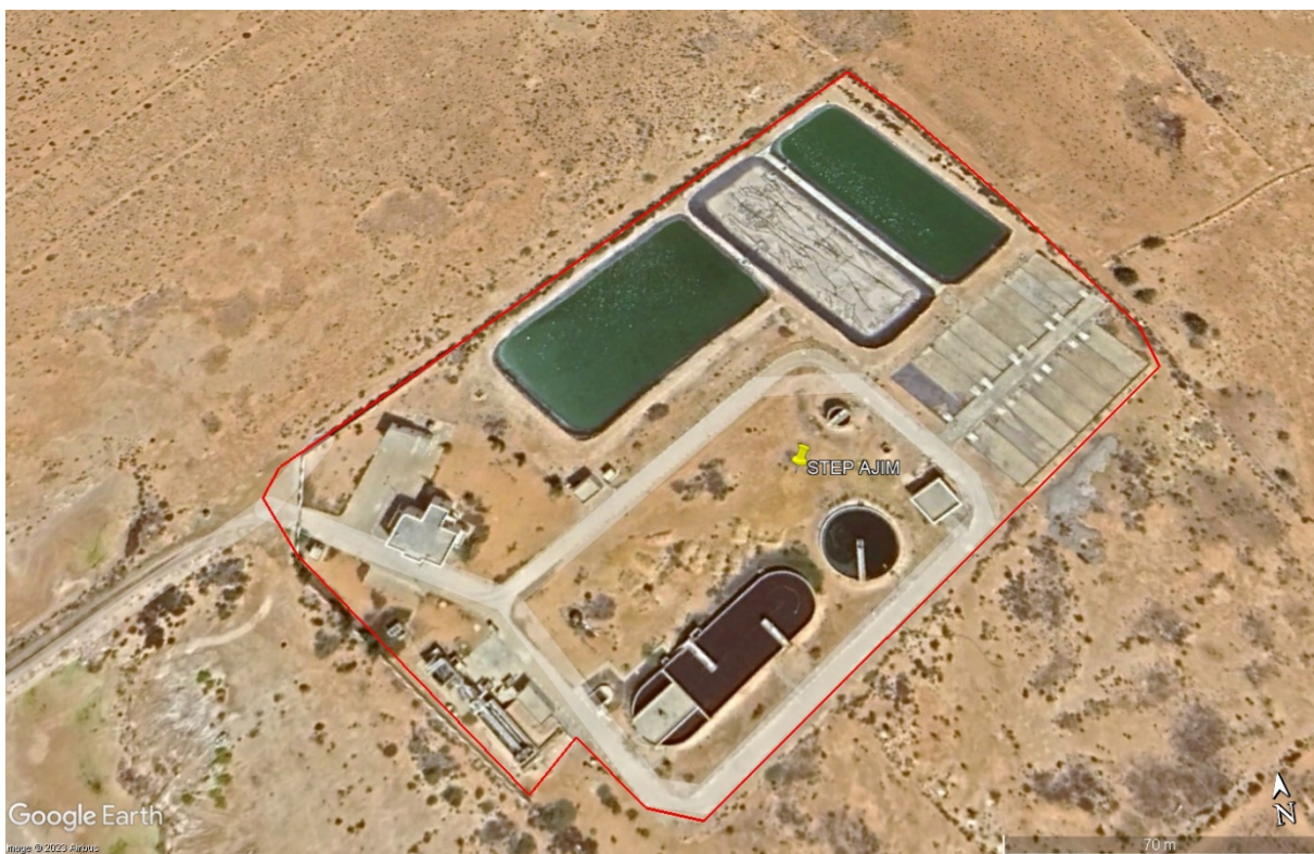
Figure 7 : Zone d'intervention de la STEP de Djerba Ajim (STEP : 33°45'52.14"N ; 10°44'8.08"E)
