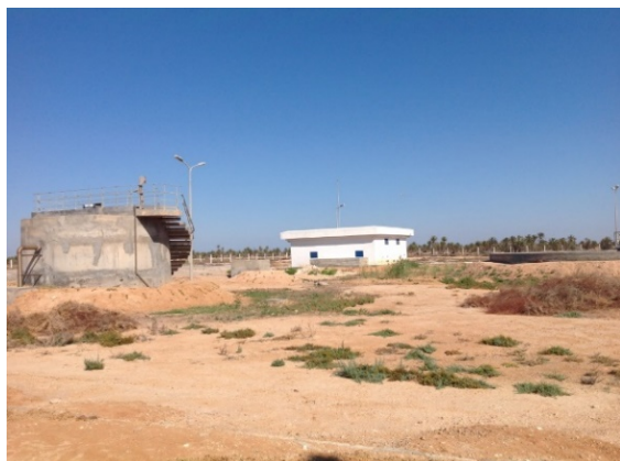
Vue partielle de l'épaississeur
