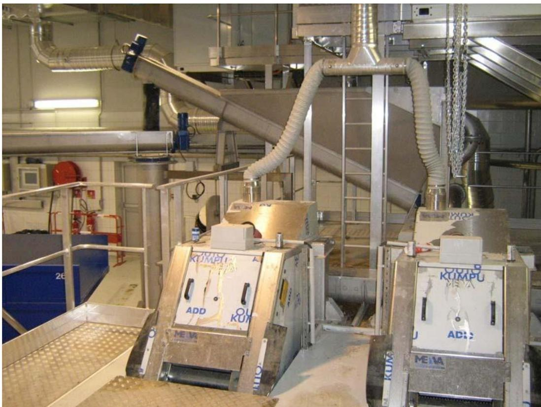
Figure 6 : Dégrilleurs automatiques couverts
