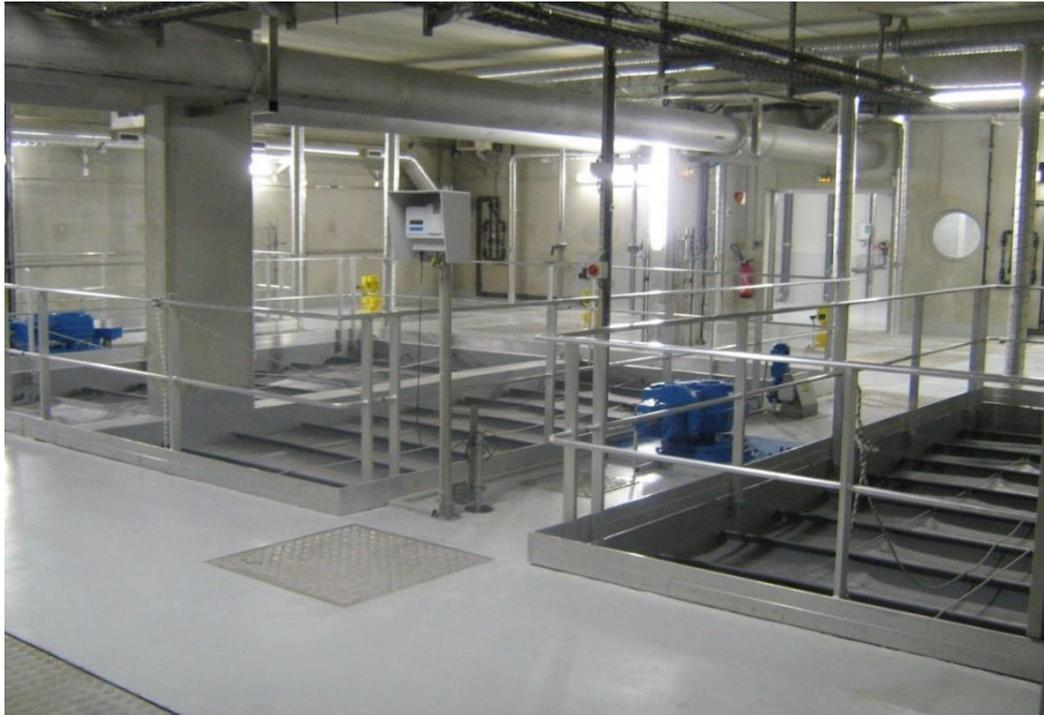
Figure 8 : Décanteur lamellaire couvert
