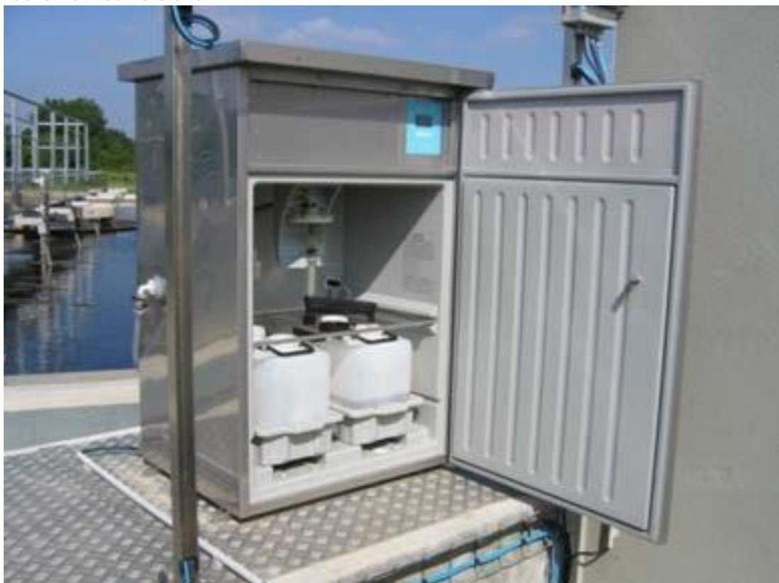
Figure 5 : Exemple de préleveur automatique
