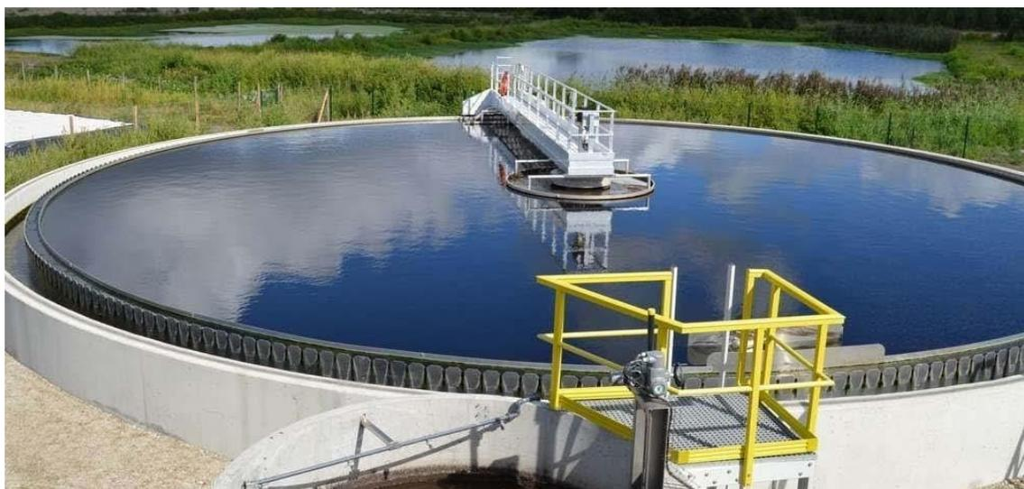
Figure 12 : Exemple de décanteur secondaire (clarificateur)
