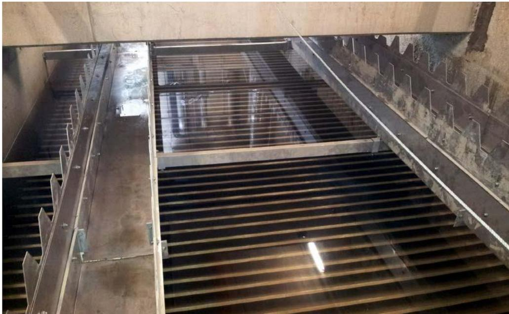
Figure 9 : Décanteur lamellaire non couvert
