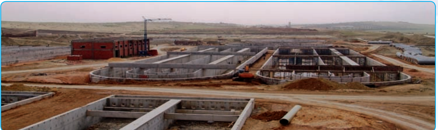
Chantier de construction de la station d'épuration de EL ATTAR
