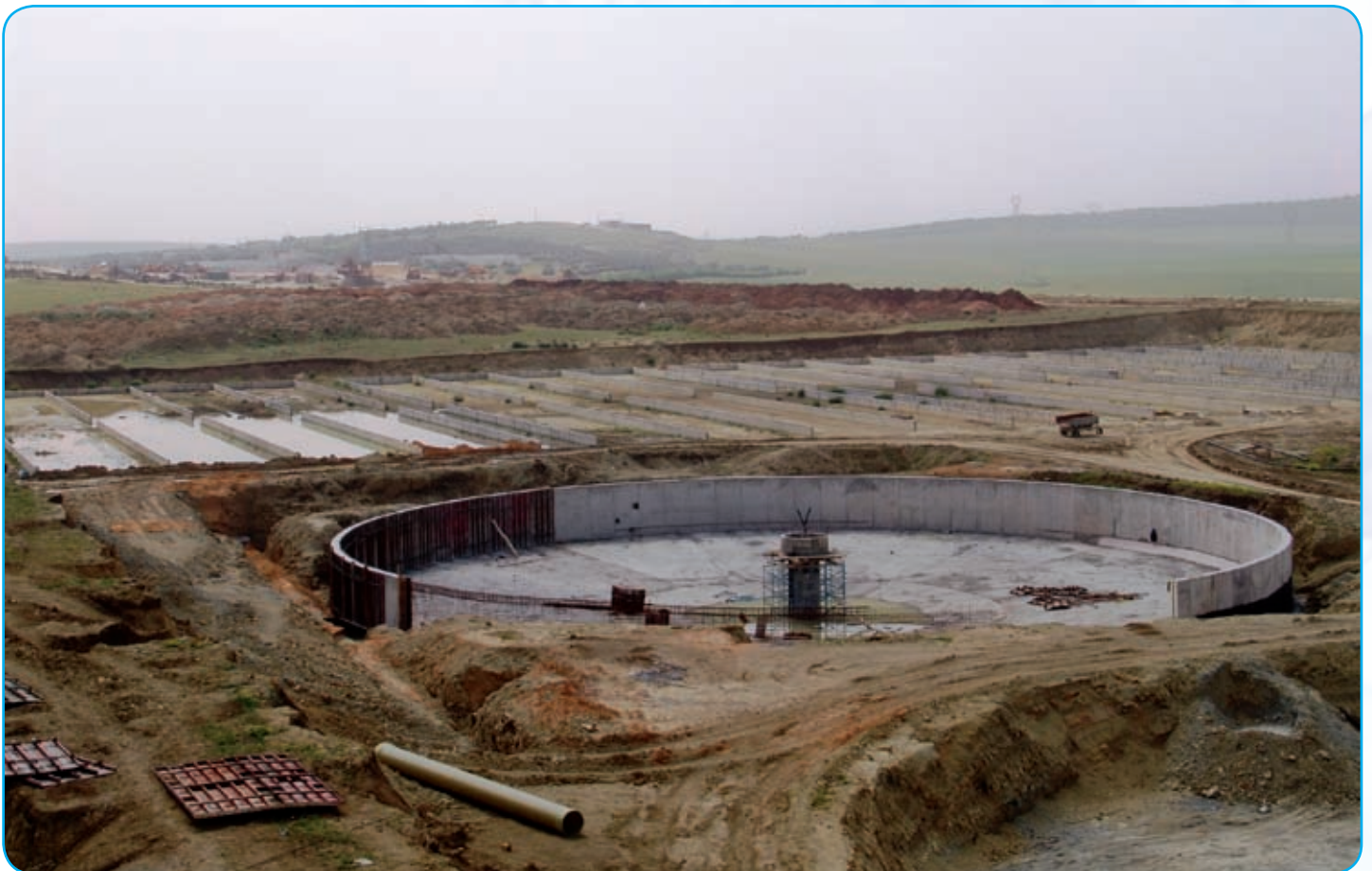
Chantier de construction de la station d'épuration de EL ATTAR
