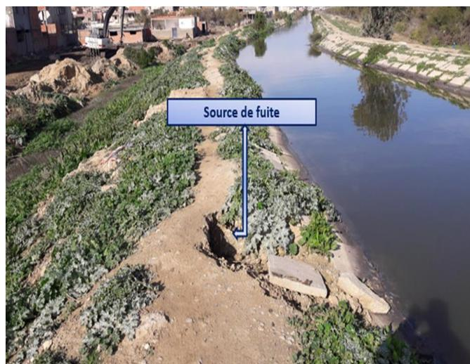
**Figure 20: Fuite des EUE au niveau provenant du canal**
